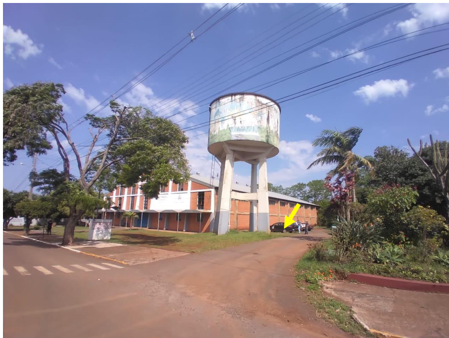
Foto 1. Localização do ponto de perfuração.
